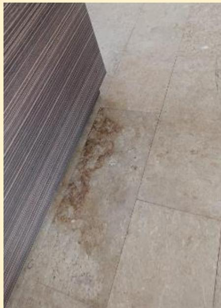
El piso de la recepción se decapado, pero la mancha del piso no se pudo retirar ya que se verifico y esa parte tiene humedad.
